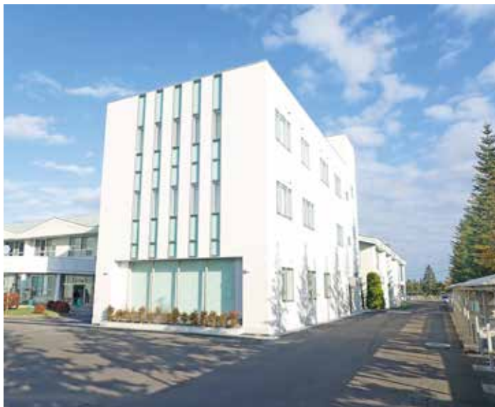
弘前医療福祉大学短期大学部口腔衛生棟新築工事
