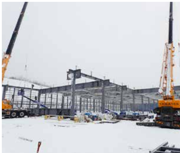
協和輸送本社社屋新築工事
